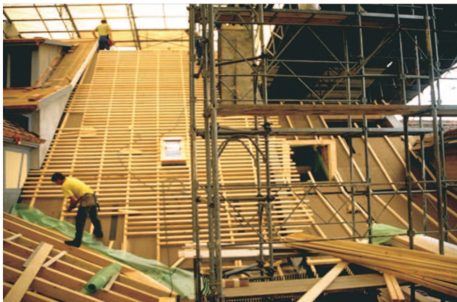
Hofatex Kombi® - sanácia starej budovy
